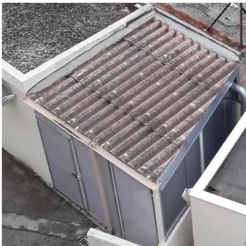
Atelier 2 (Enveloppe extérieure) - Toit - Plaques ondulées fibrociment
